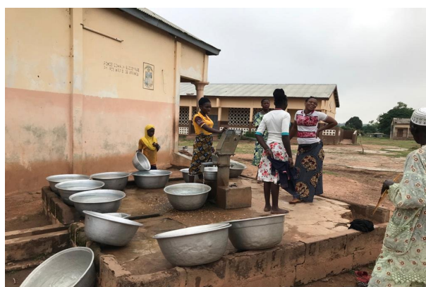
Photo 2 : Forage à motricité humaine (main)
