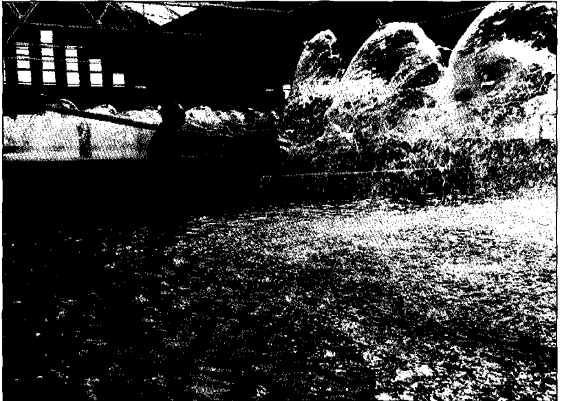
Beluchtinginstallatie in pompstation, Scheveningen (Foto Archief Vewin).
