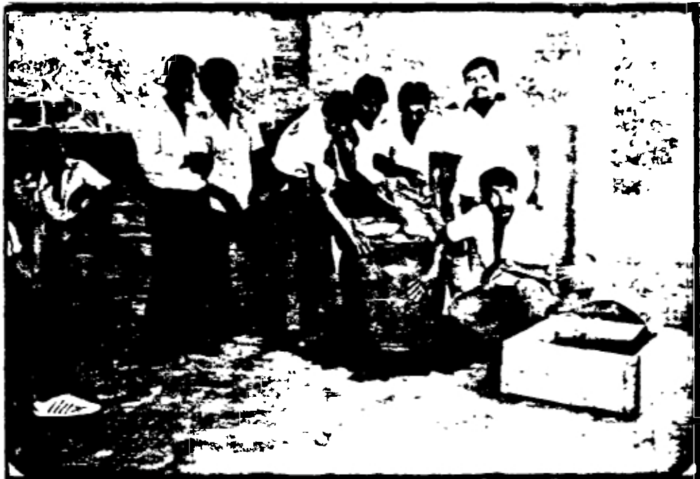
Foto . Curado exterior de la tinaja de cemento-arena. Photo . External curing of the sand/cement jar.
