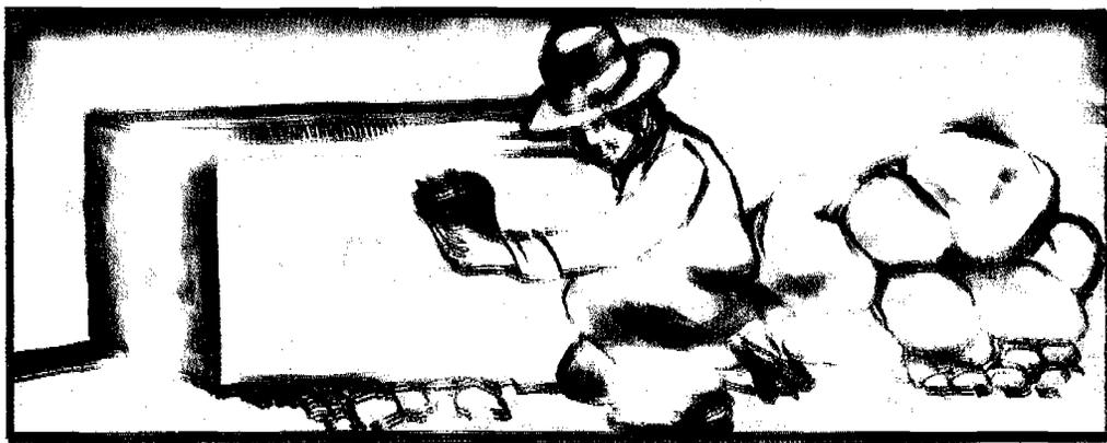
— SI LA ESTRUCTURA DE CAPTACION TIENE RAJADURAS, REPRE LA PARTE DAÑADA CON MORTERO DE CEMENTO DOSIFICACION 1:1 (UNA PARTE DE CEMENTO = UNA PARTE DE ARENA FINA).
