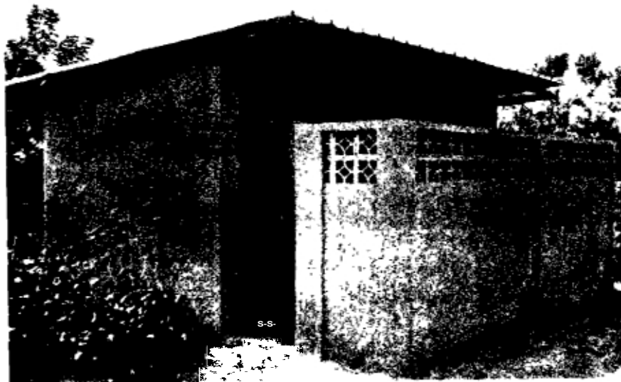
ph. Ni.2 : Toilette 5 postes en ligne
