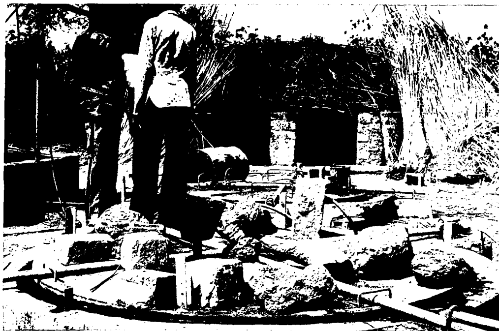
. Digesteur à paille de mil et fumier
