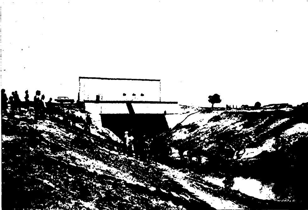
. Station et chenal d'amenée d'eau
