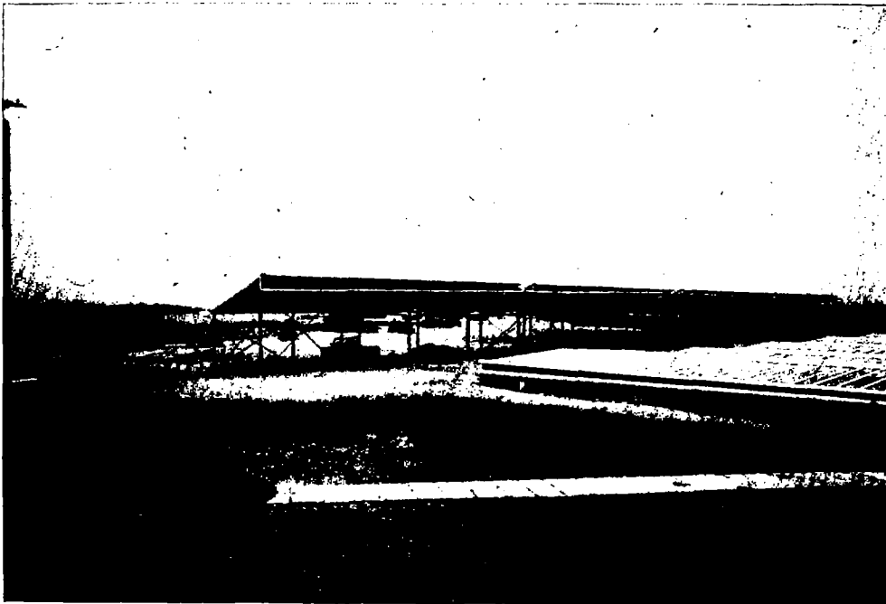
. Capteurs au sol et capteurs en toiture
