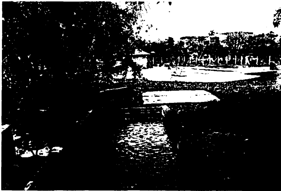
FOTO 4: El Filtro Grueso Dinámico de la Universidad Javeriana funciona como sistema de protección al sistema de pretratamiento con Filtración Gruesa Horizontal y tratamiento mediante Filtración Lenta.
