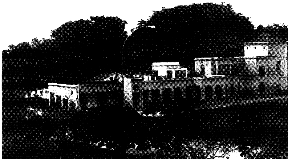
Estación de Investigación y Transferencia de Tecnología de CINARA, Puerto Mallarino, Cali, Colombia.
