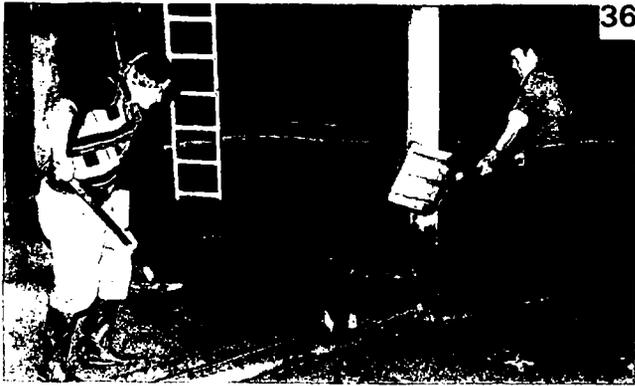
Der Sand wird in den Injektortrichter geschaufelt.
