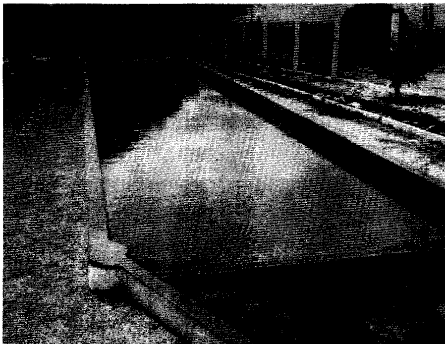
Primeiro filtro dinâmico construído na América Latina (1969) (ainda em funcionamento). Anillaco, La Rioja, Argentina
