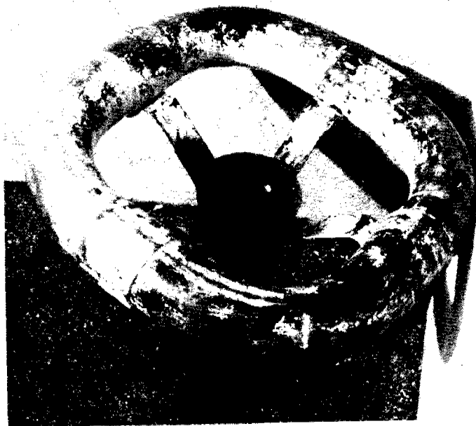
Câmara e regulador de água filtrada
