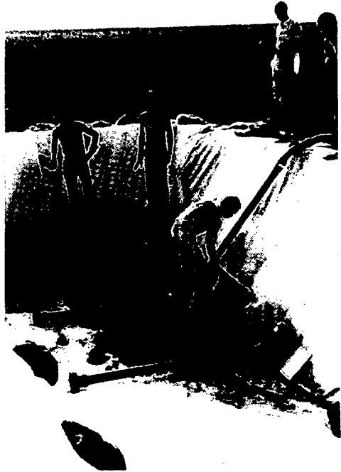
Fig. 47 Remplissage du PFH avec les matériaux filtrants (photo du Corps suisse pour l'aide en cas de catastrophes)
