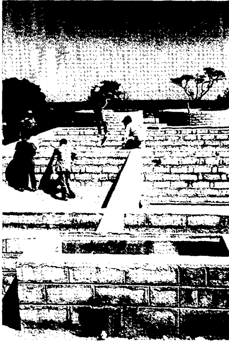
Fig. 42 PFH en construction à Kasote, Tanzanie
