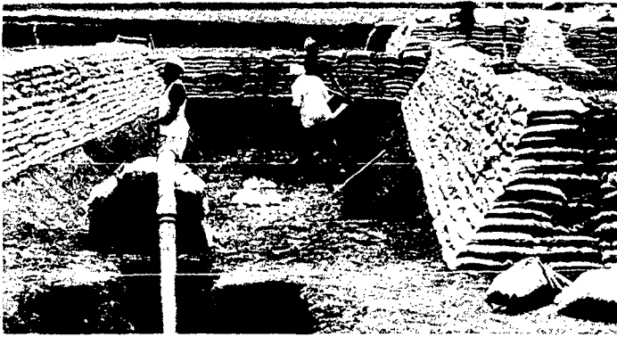
Fig. 45 Excavation du bassin en terre d'un PFH (photo du Corps suisse pour l'aide en cas de catastrophes)
