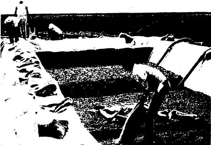
Fig. 47 Remplissage du PFH avec les matériaux filtrants (photo du Corps suisse pour l'aide en cas de catastrophes)
