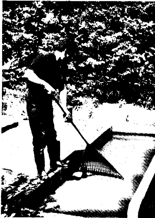
Figura 3.3. La salud de una comunidad depende del grado de entrenamiento y motivación del operador; también del seguimiento y apoyo brindado por la comunidad y las instituciones de soporte. Planta FiME, Filtro Grueso Dinámico, Colegio Colombo Británico, Cali, Colombia, 1997.
