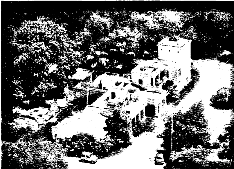
Figura 5.2. Cinara, Estación de Investigación y Transferencia de Tecnología en Agua Potable, localizada en la Planta de Tratamiento de Agua, de Puerto Mallarino-EMCALI, ACUACALI, Cali, Colombia.
