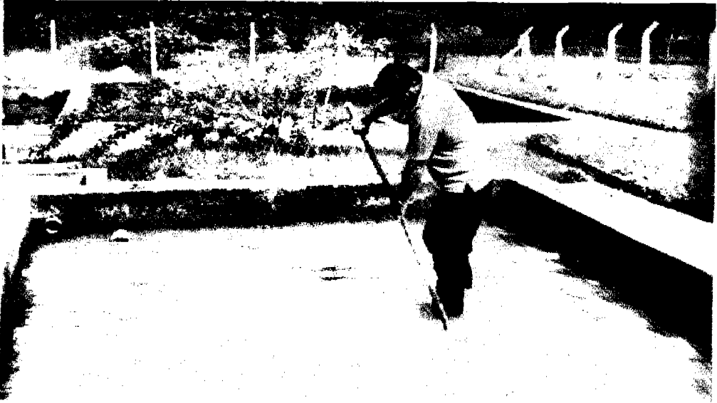
Figura 9.6. Lavado superficial de un filtro grueso ascendente en capas. Los Chancos, municipio de San Pedro, Colombia, 1997.
