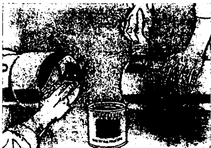
Fig. 8.57 Utilizando um pincel chato (2" x 1/4"), aplicar uma camada fina de "solda lenta" ou "adesivo" apropriados na bolsa e outra, um pouco mais grossa, na ponta do tubo. Essas operações devem ser, de preferência, simultâneas (89 *).
