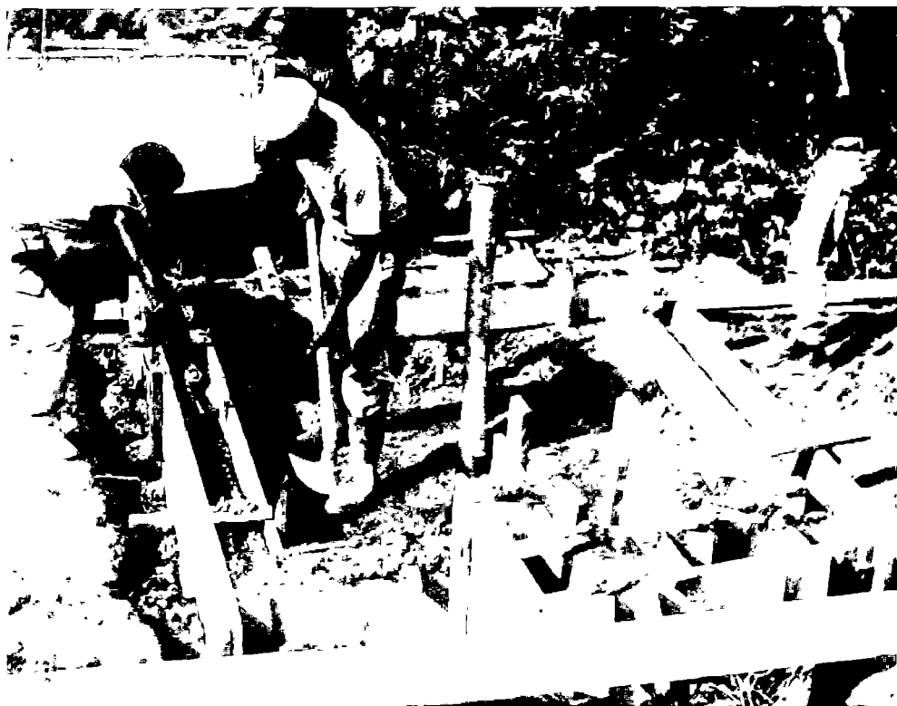
Photo 4 - Mise en œuvre d'une borne-fontaine (Gabon)
