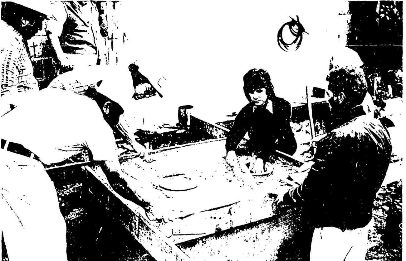
No. 14: Después del fraguado de la torta que dura 1 hora, se procede a quitar las palanganas plásticas y a efectuar los acabados.
