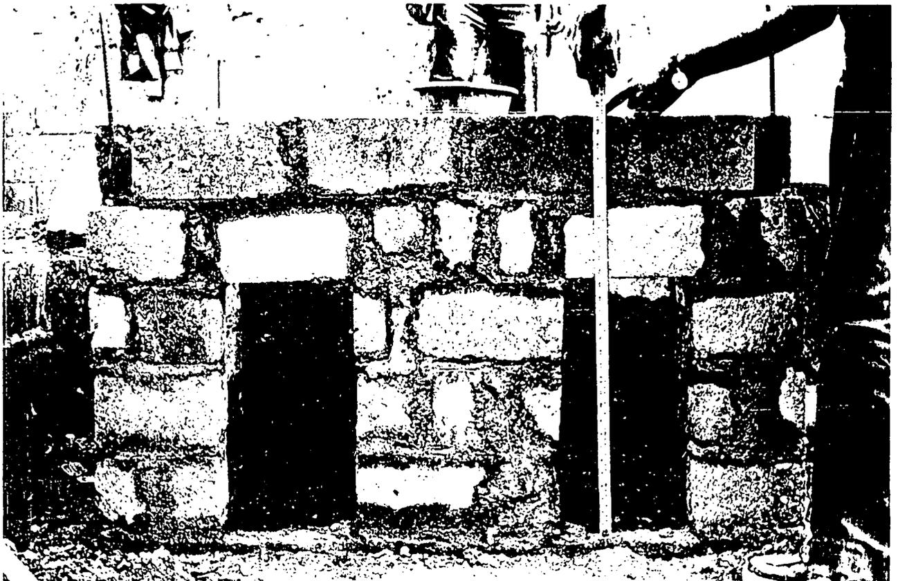
No. 10 - Encofrados: Ejecución del encofrado sobre el cual se fundirá la torta o entrepiso.
