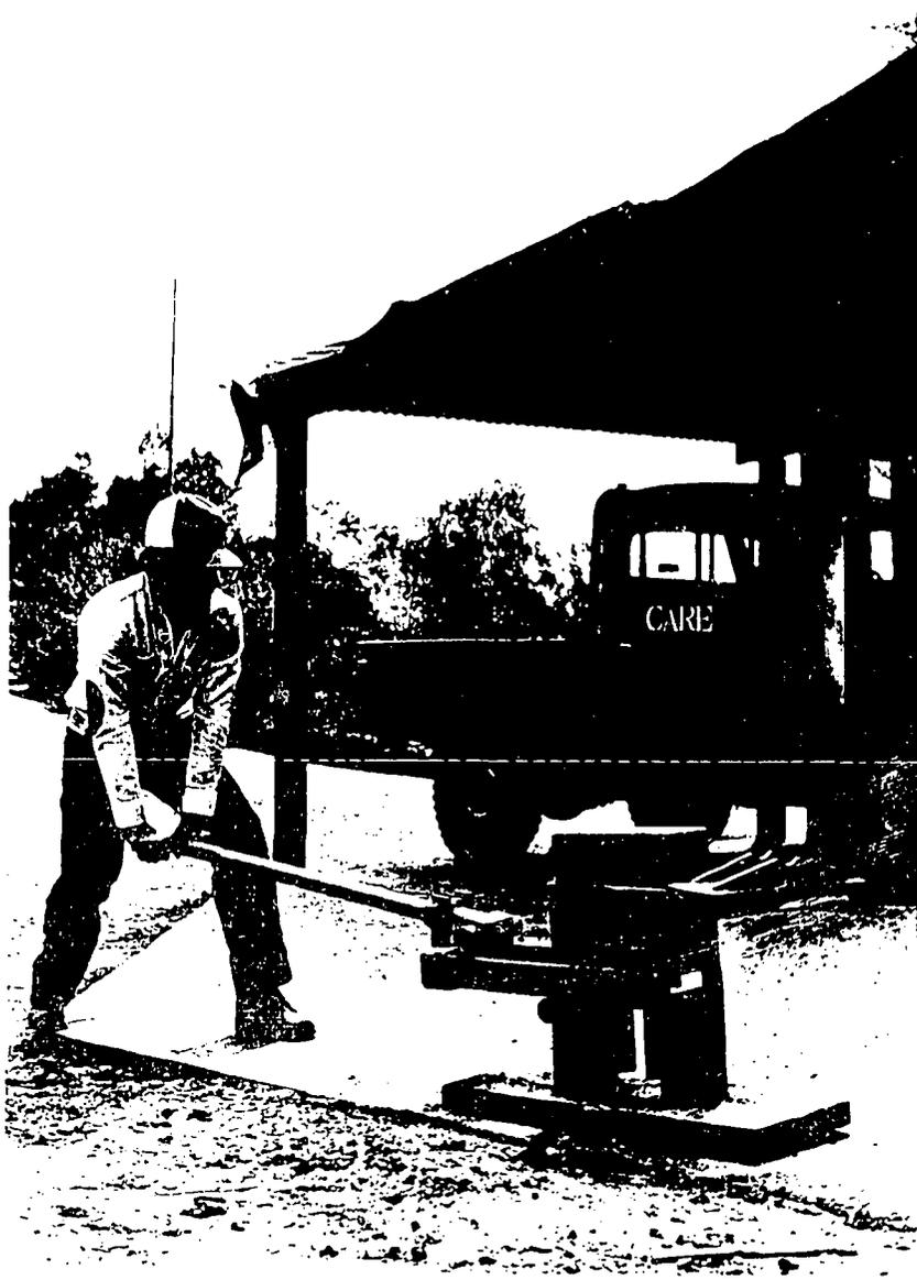
No.2: Preparación de los materiales de junta (cemento:arena - 1:3).
