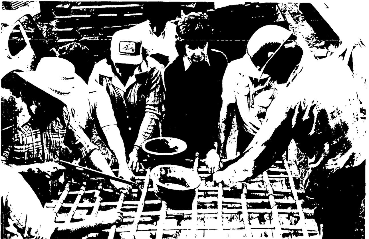
No. 12: Colocación de manguera de poliductón de 1" de diámetro - la manguera mide 1 metro de largo y se coloca a 3 pulgadas del borde de la palanquilla y se sella en un extremo.
