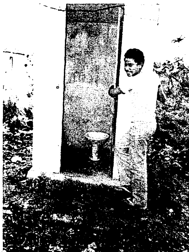
Fig. 2. Pour flush latrine.
