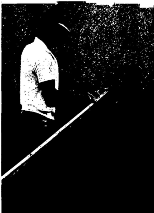
Primera y segunda planta construidas en La Robleda, Cauca construcción del casco esférico de mampos- tería con la vara de guía
