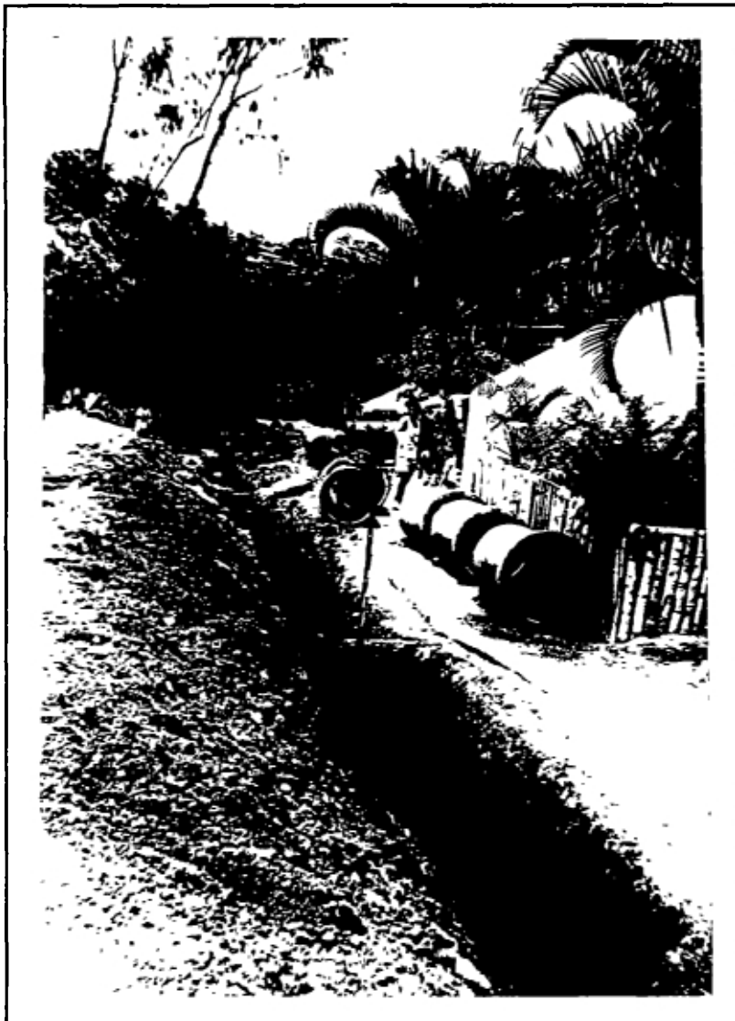
Foto 3. Instalación de la red de alcantarillado, La Sirena, Cali.
