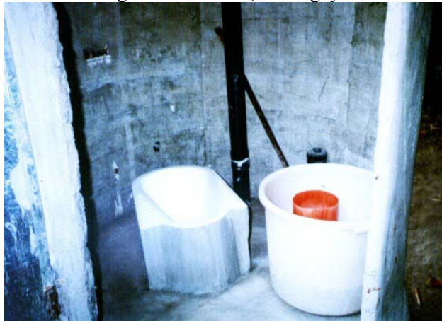
Elevated squat plate, pour flush type, Barangay 13
