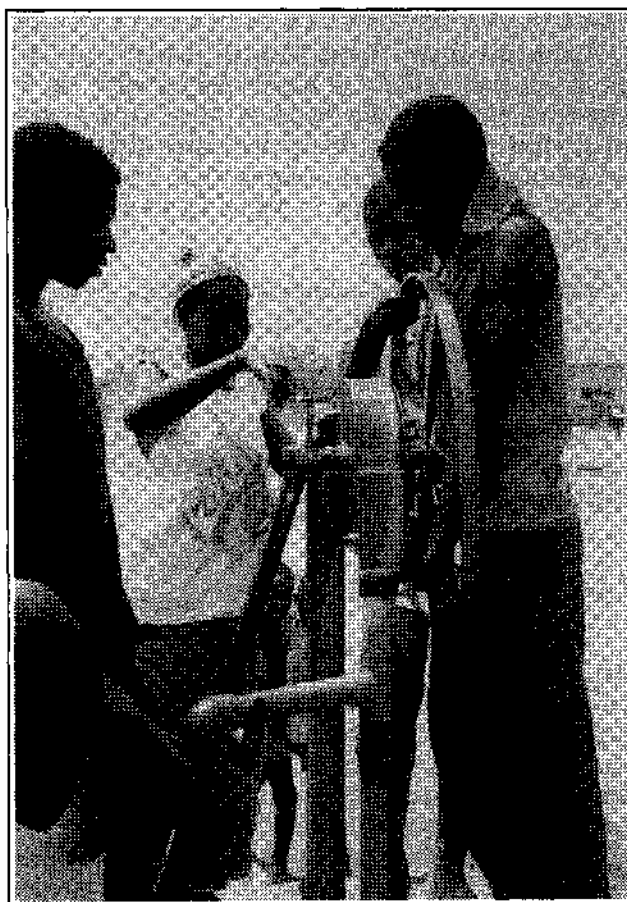
Le démontage et le remontage complet de la pompe B.B. s'effectue sans outil grâce à des vis - poignée et à la facilité d'extraction du piston. Celui-ci utilise la colonne d'exhaure comme cylindre.
