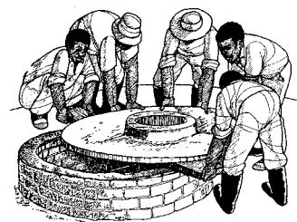
Ponga la losa curada en su lugar.
