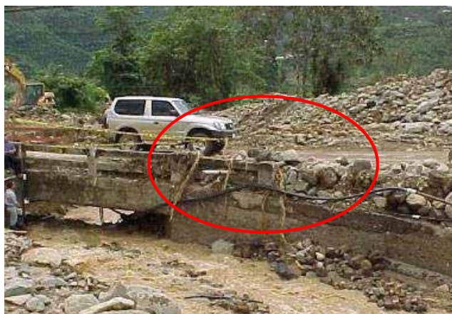
Fotografía 4: Reconstrucción de un acueducto rural Fuente: Arturo Rodríguez, 2003.
