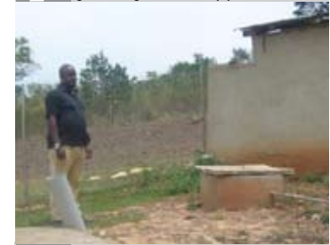
→ Inside the pouflush toilet
