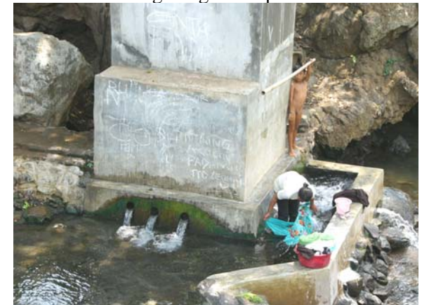
Bak/Sumur Penangkap Mata Air (Bron Kaptering) Desa Paras
