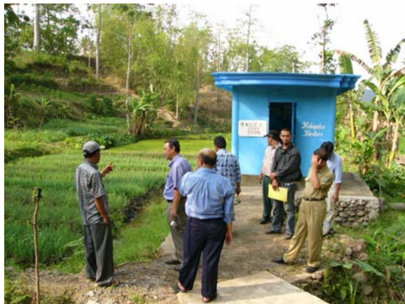
Rumah Pompa untuk Mendorong Air ke Daerah Pelayanan
