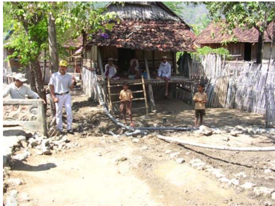
Proses Pemasangan Pipa
