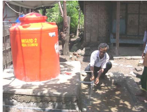
Bak Penampung Air & Kran Umum
