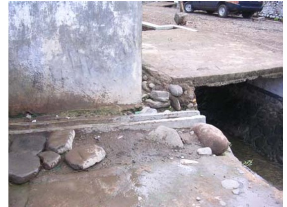
SPAL yang Dibuang Langsung ke Aliran Sungai
