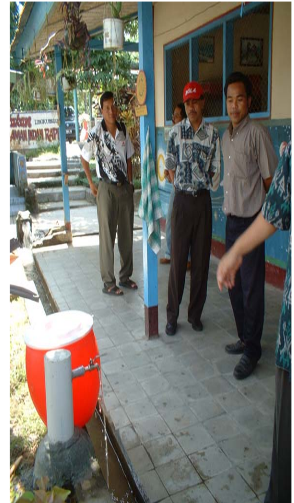
Fasilitas Keran Air Bersih di SD Batukumbung
