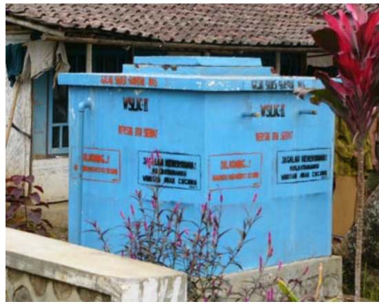
Salah Satu Contoh Terminal Air/ Hidran Umum
