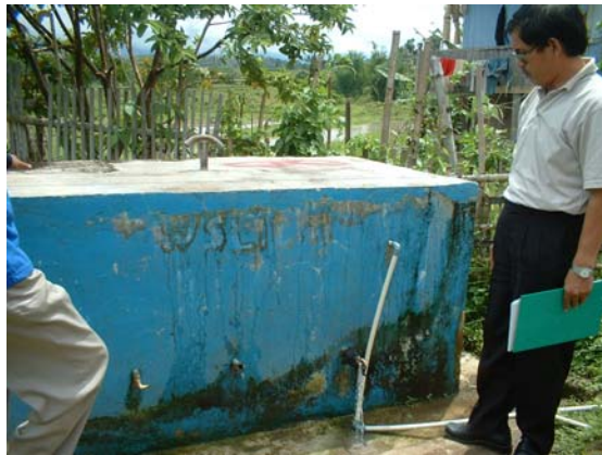
Bak Penampung Sekaligus Keran Umum
