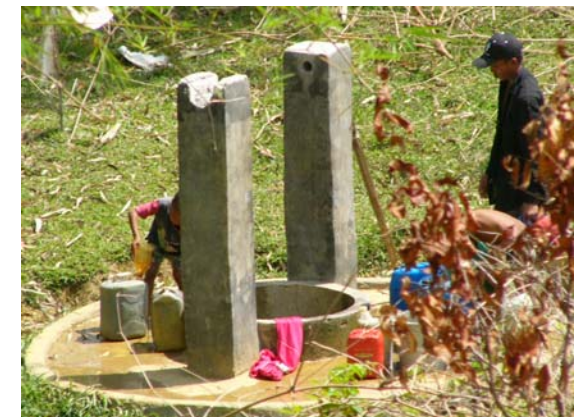
Salah Satu Contoh Sumur Dangkal yang Banyak Dimanfaatkan Penduduk
