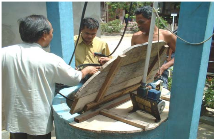
Sumur WSLIC-2 yang Dilengkapi dengan Pompa Swadaya Masyarakat (Pribadi)
