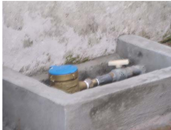
Gambaran Sistem Perpipaan Air Bersih yang Dilengkapi Meteran Dimana Air Sampai di Rumah (Kamar Mandi) atau di Halaman (Kran Umum)
