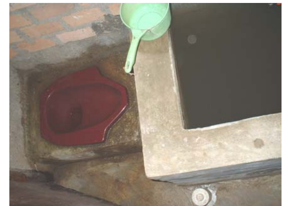
Posisi Kloset yang Kurang Ergonomis (Lihat Posisi Kloset-Bak)
