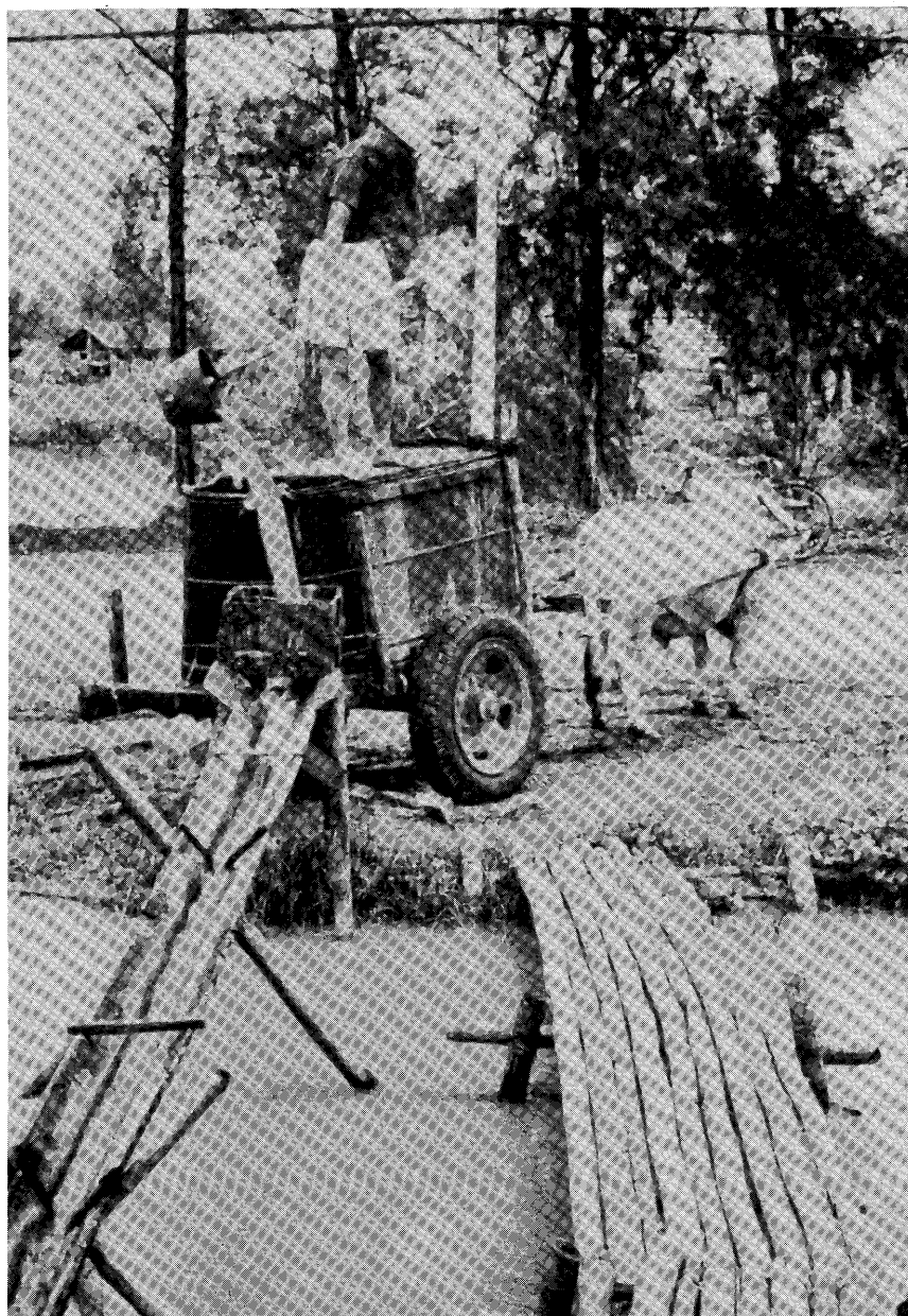
Fig. 2.3 Déversement de gadoues dans les bassins de pisciculture en Chine
