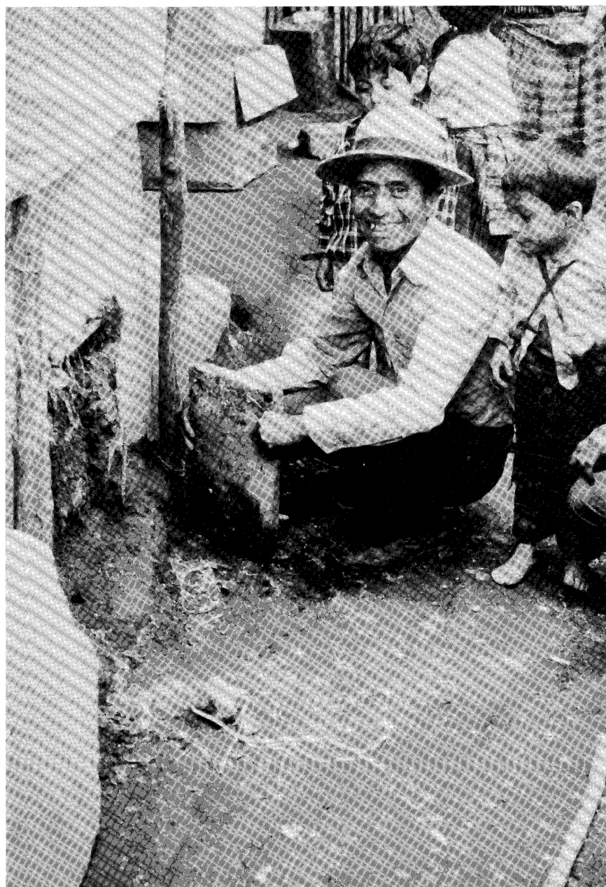
Fig. 3.3. Vidange d'une latrine LASF au Guatemala Les excréta digérés sont ensuite répandus sur le sol
