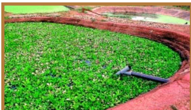
Etang de stabilisation des égouts à travers l'utilisation de la laitue aquatique à l'usine de traitement des eaux usées de l'EIER, Ouagadougou.
