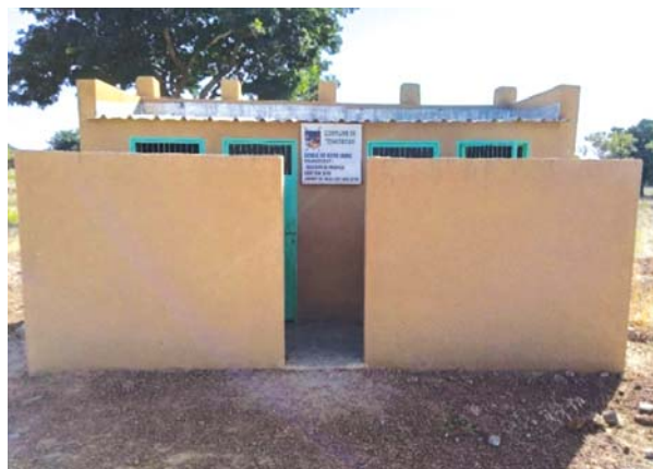
Latrine de l'école de KERÉ HORE
