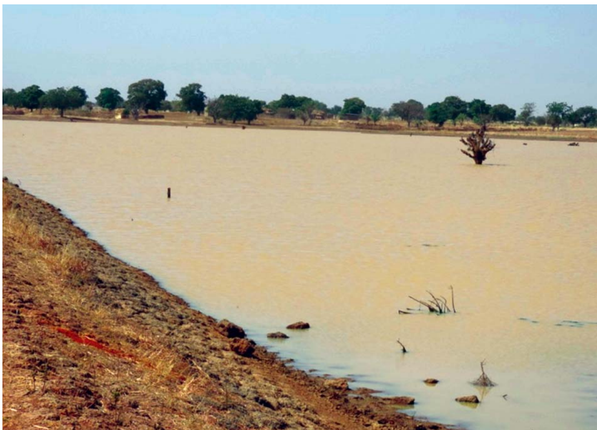
Barrage de Silmiougou, IRC/Janvier 2021
