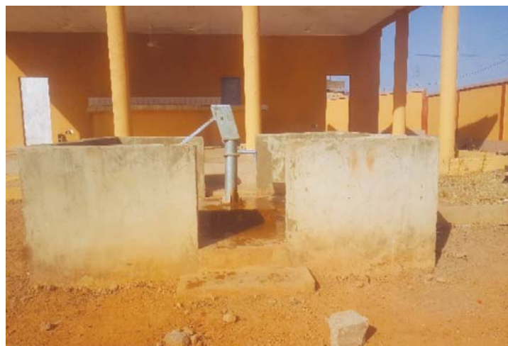
CSPS équipé PMH
